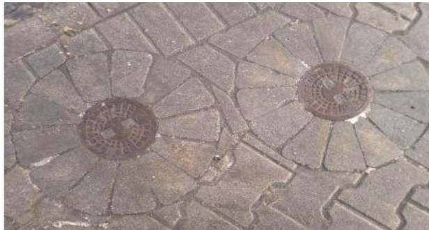
fot. obróbka armatury wodociągowej
